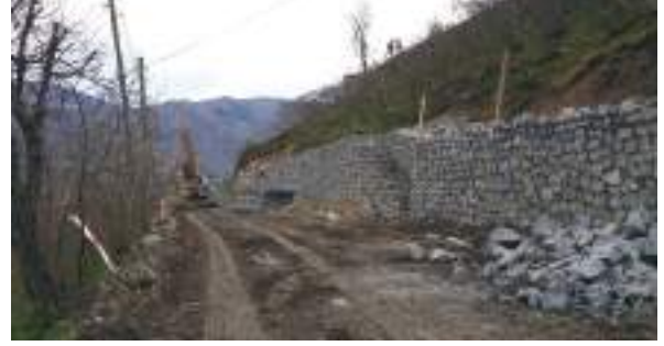
Ulubey İlçesi Kiranyağmur – Durak – Güvenyurt – Koşaca Mahalle Yolu / Yol Genişletme Ve Taş İksa Duvarı İmalatı Çalışmaları
