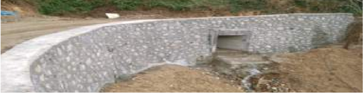
Altınordu İlçesi Orhaniye Köyü Taş Duvar Ve Menfez Yapım İşi
