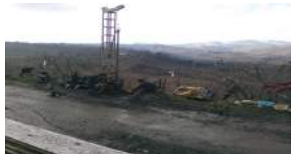
Gülyalı İlçesi Mustafalı – Ayrılık Mahalle Yolu Heyelan Bölgesi Sondaj ve Zemin Etüdü Çalışmaları
